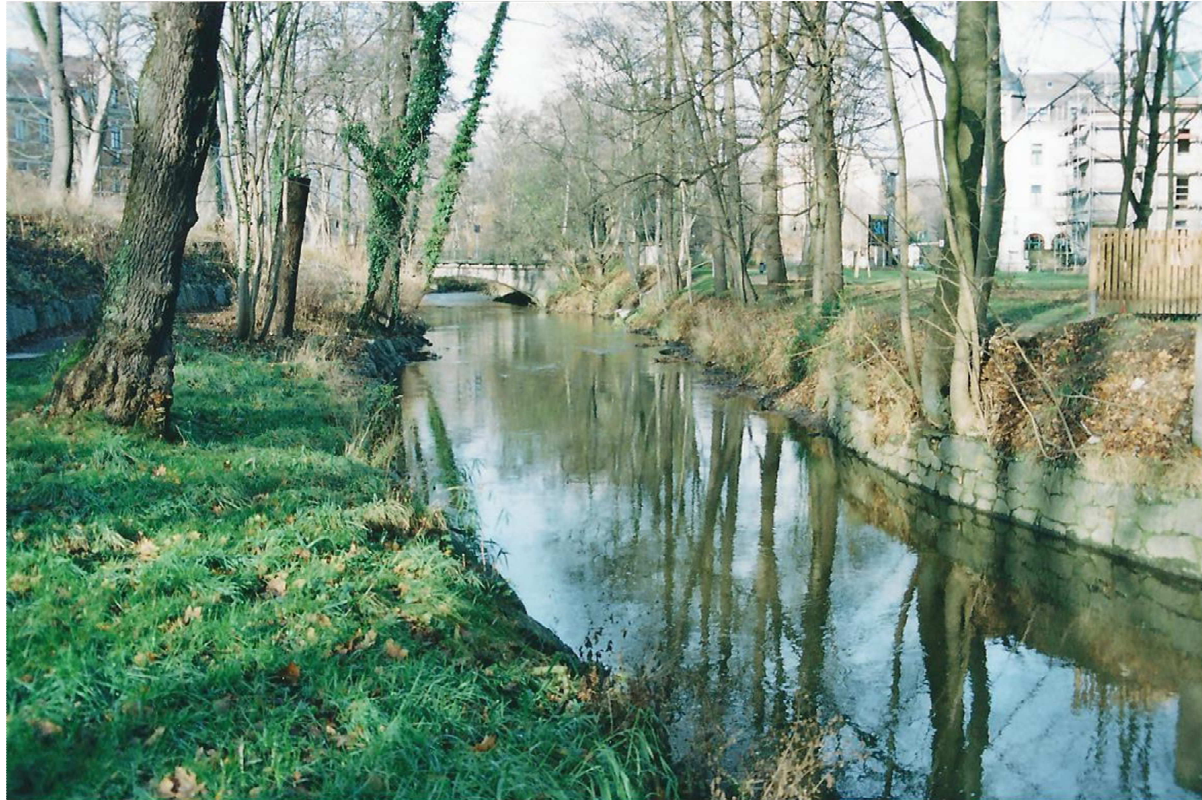
Blick auf Gelbkehain und Röderbrücke Dresdener Straße
