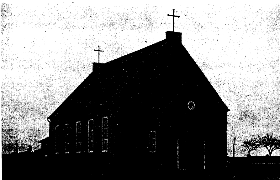
Kapelle (ev. Kirche) in Dittersbach, erbaut 1930/31. Aufnahme: W. Langer, Dittersbach.
